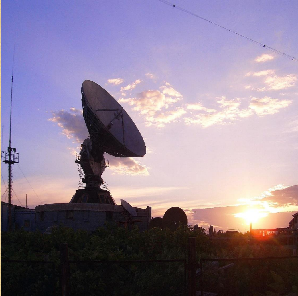
Телевизионная станция космической системы связи
